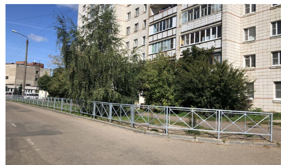
► Установлены металлические ограждения со стороны Детской поликлиники №5
