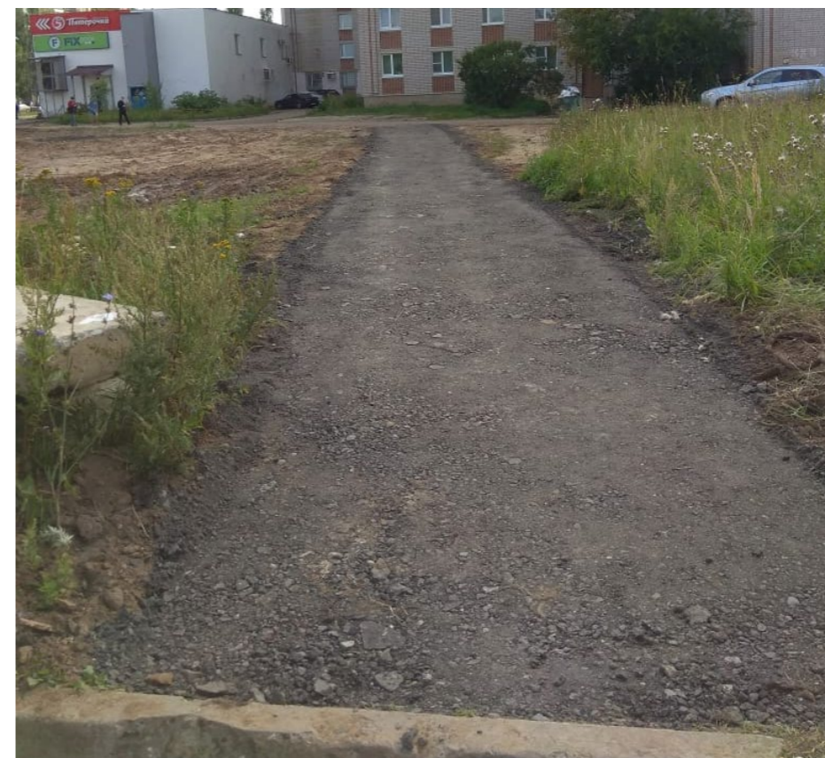
▶ Выполнено обустройство тротуара из асфальтовой крошки между домами ул. Самоковская, 2 и 4а
